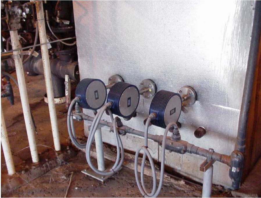
Abb. 6. Version mit eingebundener Übertragungseinheit. Ausreichend lange, feuchtigkeitsdichte Flex-Anschlüsse aus Liquid Tight Conduit ermöglichen Demontage ohne Abkoppeln des Kabels
